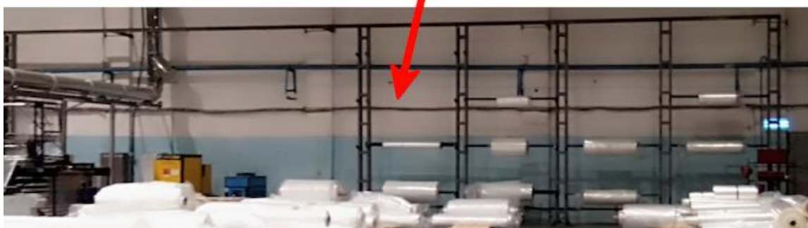
Рисунок 4.14. Проблемные точки 24, 25. Производственные склады
